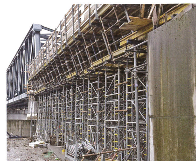
4. Fase 1: i tralicci e i casseri in posizione
