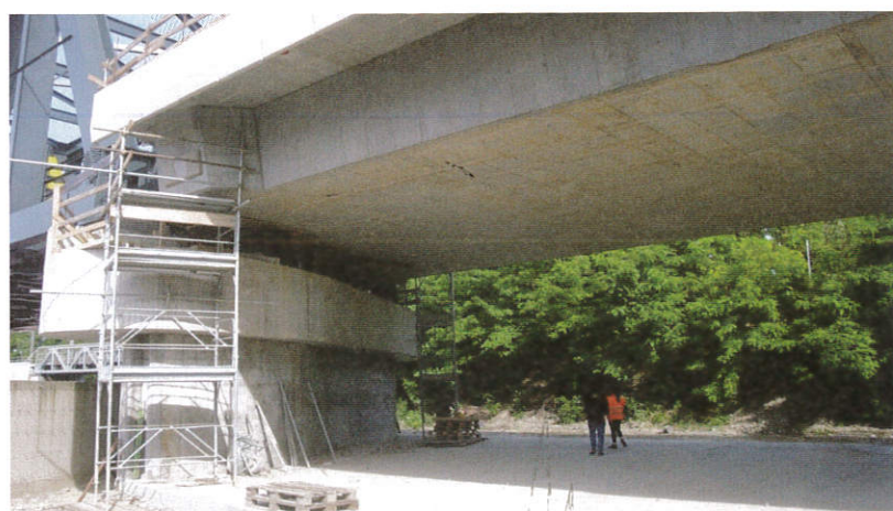
1. Vista dell'impalcato lato Padova, spalla B
