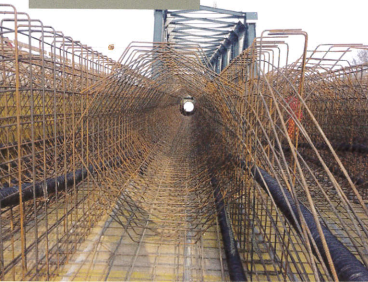
7. Fase 2: l'armatura lenta dell'impalcato
